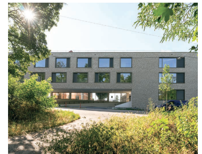
Das Schulgebäude öffnet sich – auch baulich – zur Straße hin.
