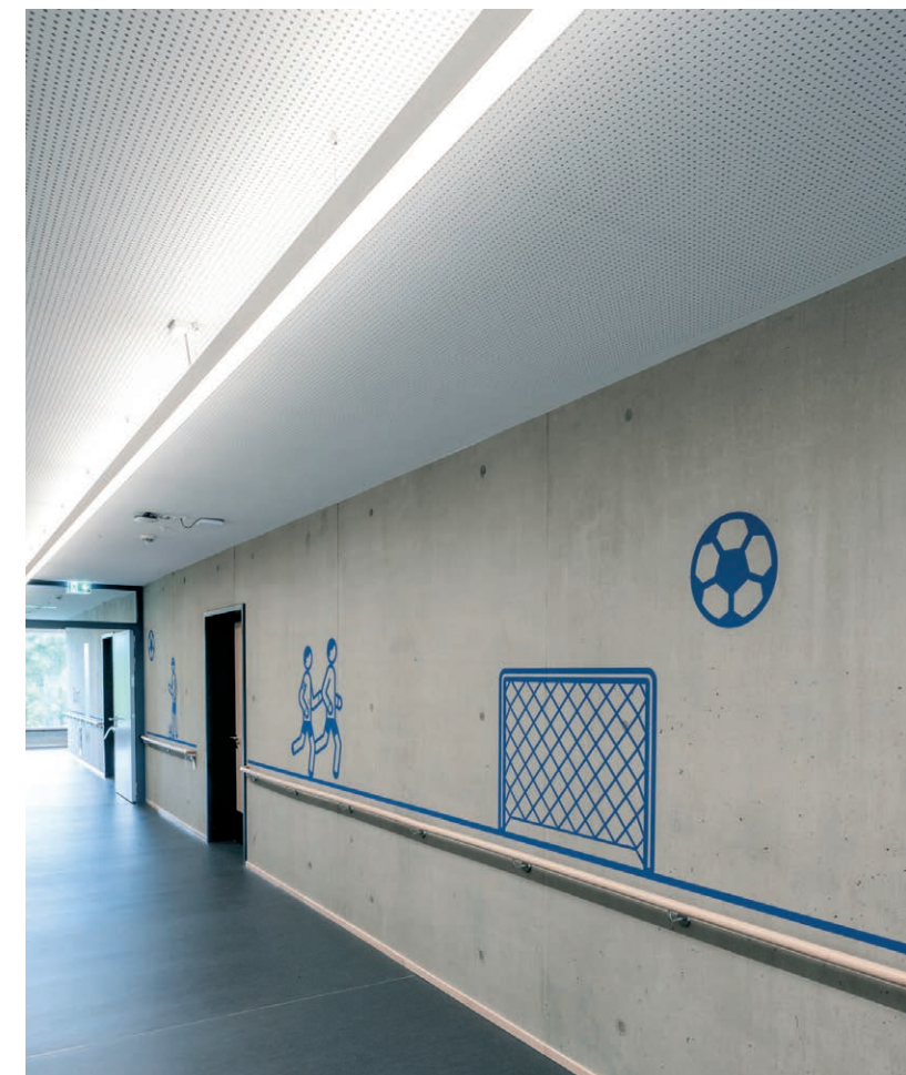
Gleichmäßig orientiert: Großflächige deckennahe Leuchten leiten auf den Fluren.
