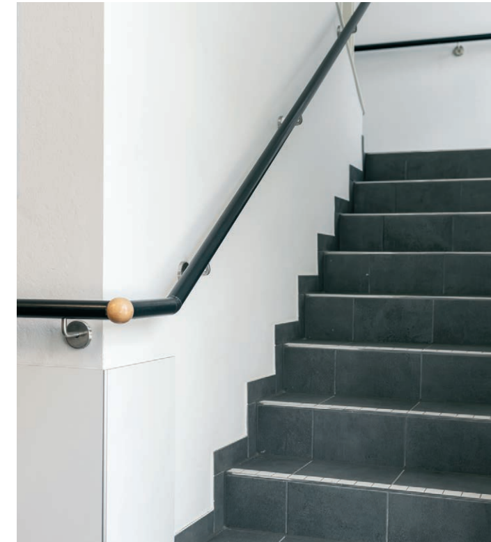
Die Treppengeländer heben sich deutlich ab.
