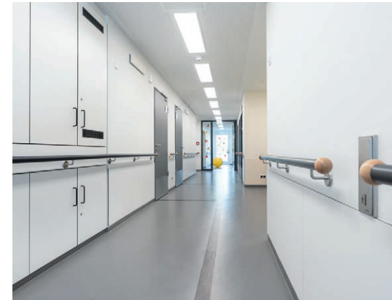
In den Fluren wurde mit Einbauschränken Stauraum geschaffen.
